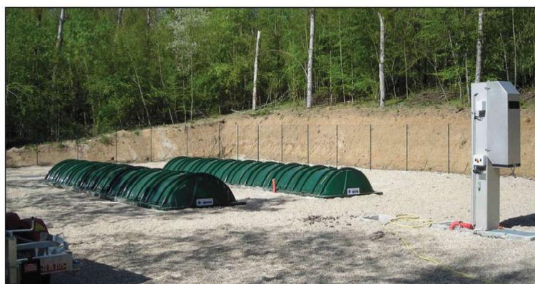
2 stations BLIVET en parallèle, précédées d'un dégrilleur automatique
